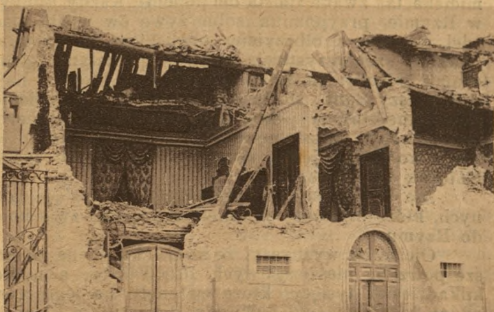
Widok domu zniszczonego trzęsieniem ziemi.
