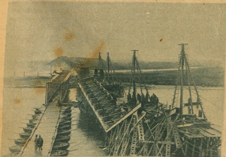
Most kolejowy przez Warę, zniszczony i odbudowany.
