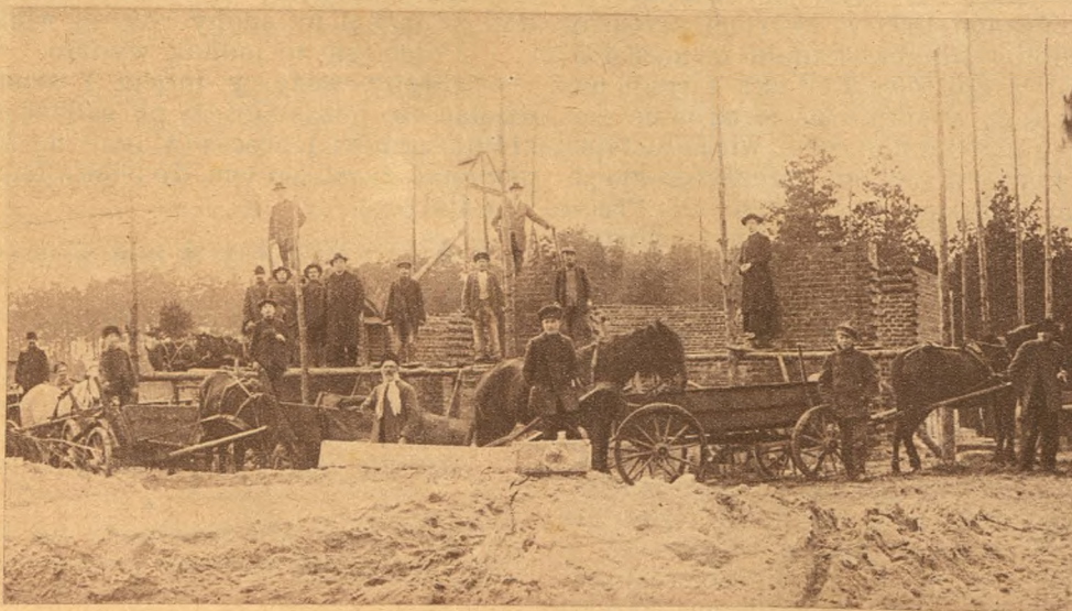
Budowa XII stacyi kaplicy Ukrzyżowania Pana Jezusa.
