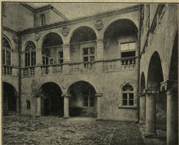
DZIEDZINIEC DOMU PRZY UL. KANONICZNEJ L. 21. W KRAKOWIE
