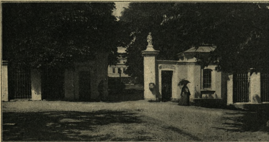
BRAMA WJAZDOWA ZAKŁADU W NAŁĘCZOWIE PRZED PRZEBUDOWĄ.
