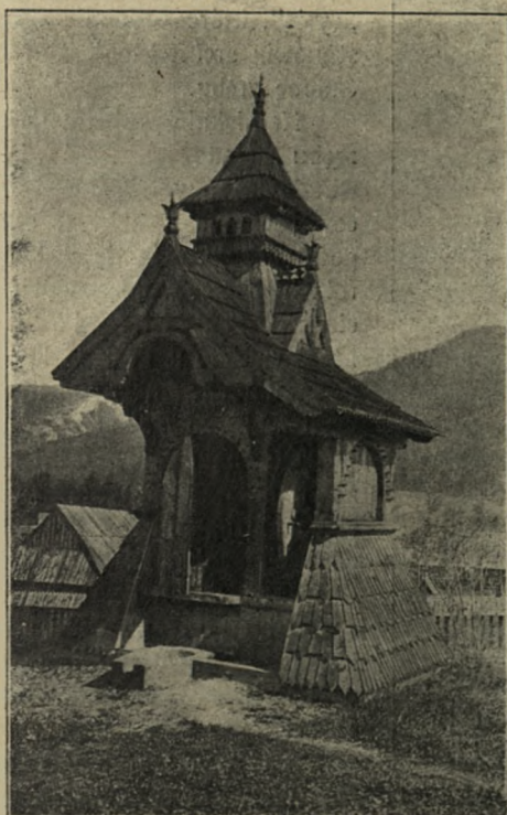
STUDNIA PRZY DOMU „POD JEDLAMI“
