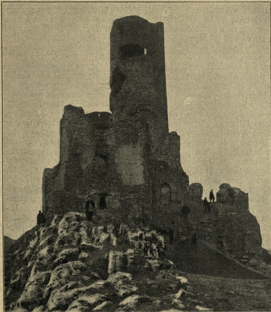
BASZTA WJAZDOWA ZAMKU CHECIŃSKIEGO I RESZTKI BRAMY
