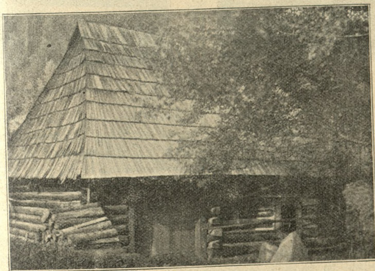
Ryc. 31. Chałupa w Piwnicznej na przedmieściu «Niewinna».
