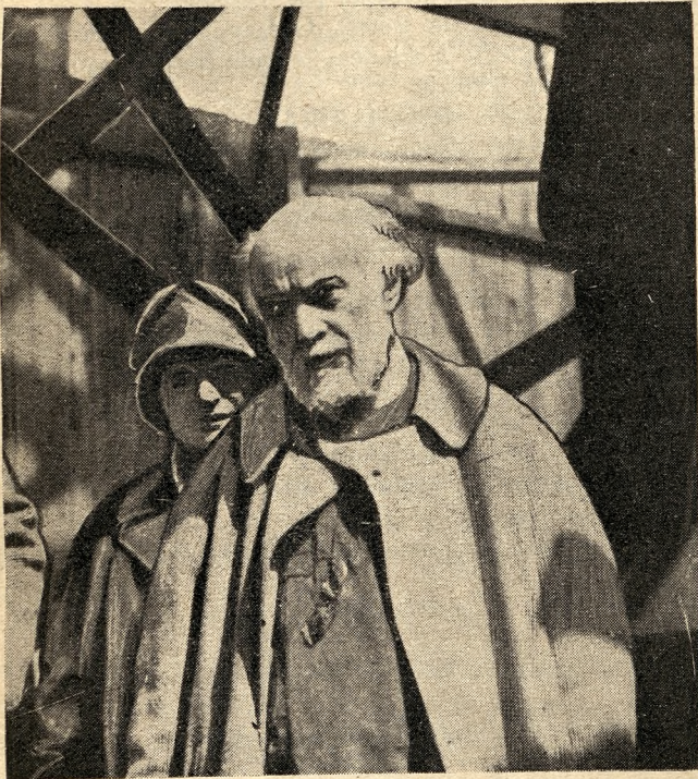
E. A. Bourdelle—na tle rusztowań przy wznoszonym pomniku Mickiewicza
