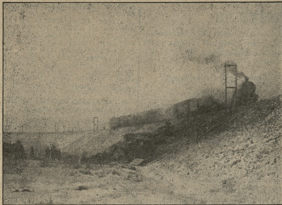
Na torze widoczny pociąg z Wroniek, który spowodował katastrofę. Pod skarżą rozbite wagony, z pod których wydobywa się zabitych i rannych.
