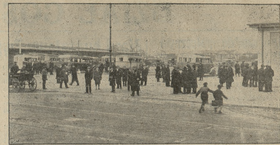
Poznań doczekał się wreszcie dworca autobusowego. Niemal w tem zasługę ma „Kurjer Poznański”, który stanął na czele akcji, domagającej się scentralizowania poznańskiego ruchu autobusowego. Widoczny na zdjęciu dworzec przy Pl. prez. Drwęskiego, skupił od kilku dni cały ruch autobusowy. Dziennie przechodzi tu około 160 autobusów.
