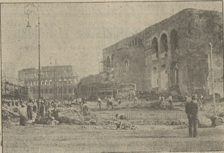
Oto jeden z fragmentów prac, przeprowadzanych na szeroką skalę przez Mussoliniego w Rzymie, aby wydobyć na powierzchnię zabytki prastarej Romy, a równocześnie znieść dzielnice, które tylko szpeca „Wieczne Miasto” i są siedliskiem wszelkich chorób.
