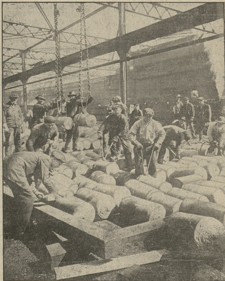
W amerykańskiej fabryce pocisków armatnich, która mimo kryzysu gospodarczego ma smac jednak jeszcze zamówień poddostatkiem. Uwidocznione na zdjęciu bloki stalowe będą wydrążone i obłożone na czerepy do pocisków.
