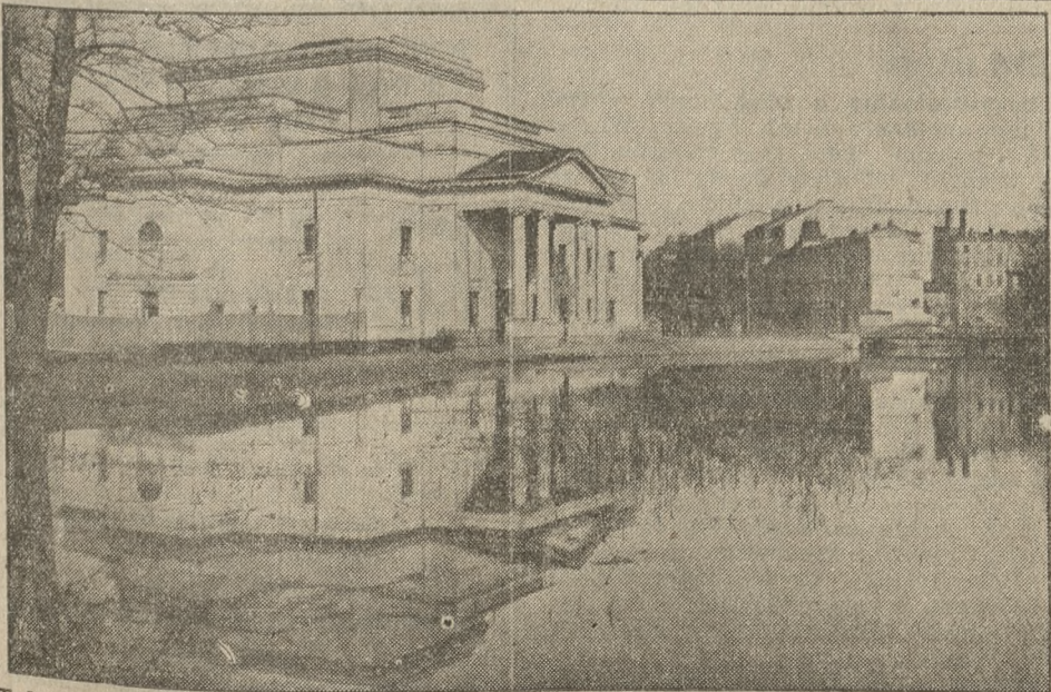
Tak wygląda nowy piękny gmach teatru w Kaliszu od strony Prozny. Zbudowano go na miejscu dawnego budynku, zburzonego przez Niemców.
