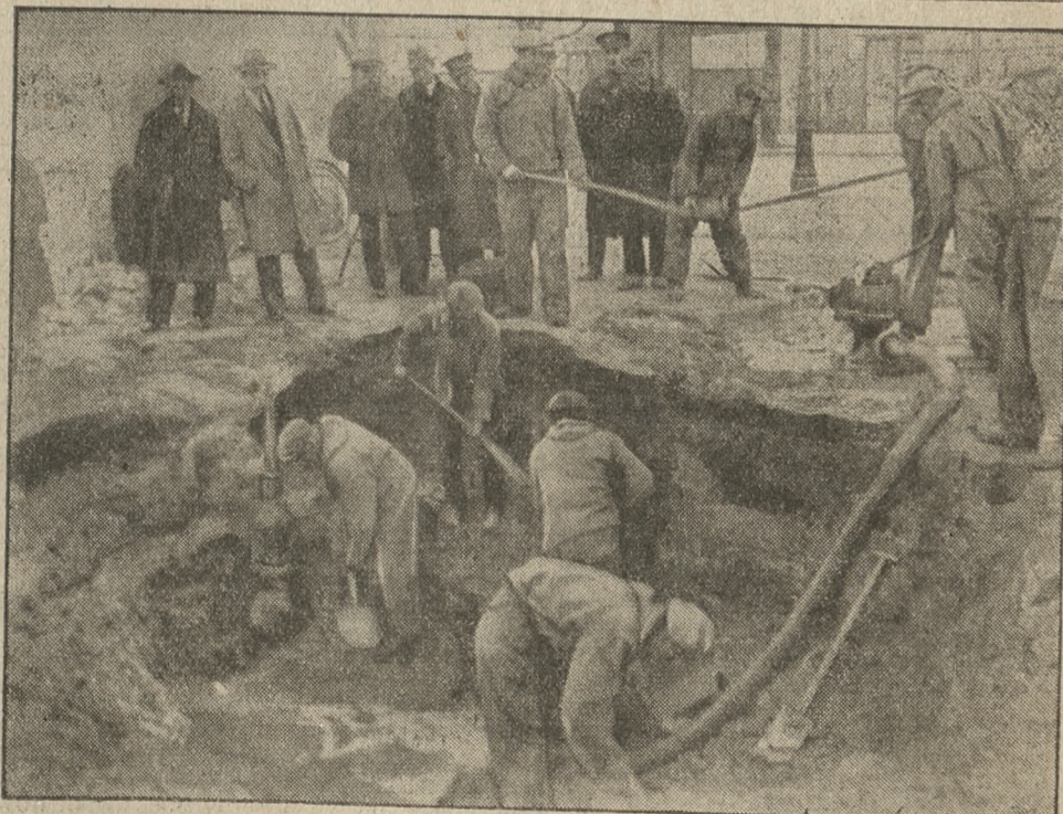
Z powodu pęknięcia głównej rury w wodociągach poznańskich, miasto było późną nocą przez około godzinę bez wody. Ilustracja przedstawia prace w wyrwanym przez wodę otworze głębokości półtora metra przy Walach Królowej Jadwigi naprzeciw boiska Sokola. (k)
