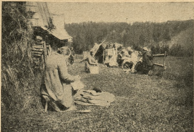
W niepewną pogodę — praca przed chatą.
