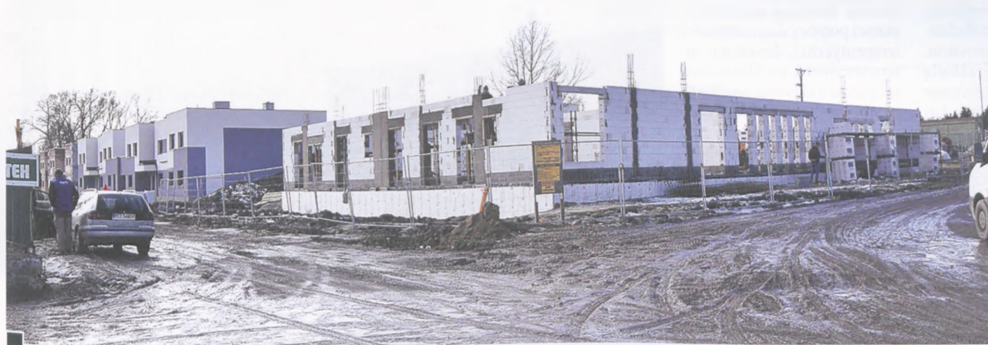
Budynek Publicznego Przedszkola „Fantazja” przy ul. Chudzickiego „wychodzi” z ziemi. Prace rozpoczęto 1 grudnia 2018 r., ma być gotowy na 1 października br. Zgodnie z tablicą informacyjną, będzie w nim też lokal mieszkalny fot. Piotr P. Ruszkowski
