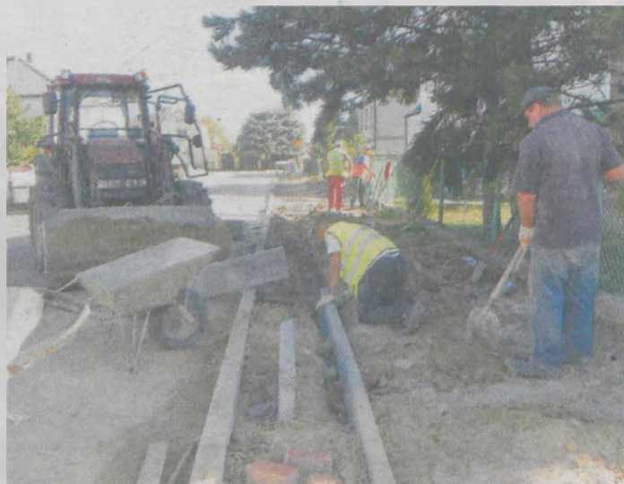
(seb) Prace na ul. Malinowskiego dobiegają końca
