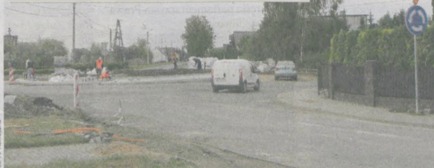
Przebudowa całego odcinka drogi Witaszyczki - Zakrzew - granica powiatu razem z rondem będzie kosztowała prawie 6,5 mln zł (ann)
