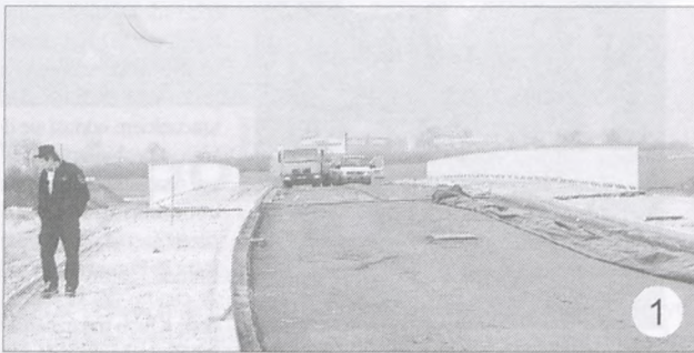
Wiadukt WD1 - ul. Traugutta - Oplotki
