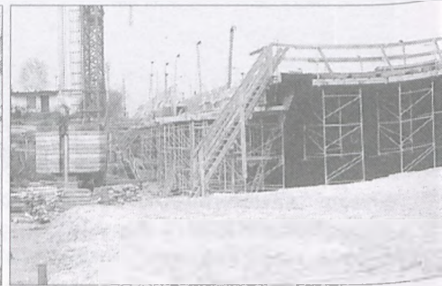
Wiadukt WD4 - ul. Żabikowska
