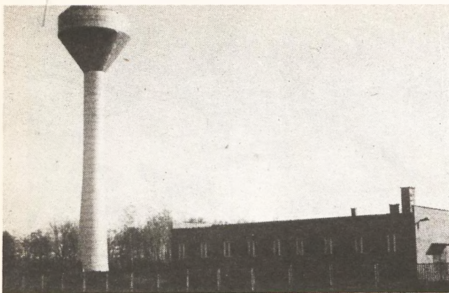
Stacja uzdatniania wody z wieżą ciśnieni w Koźminie
