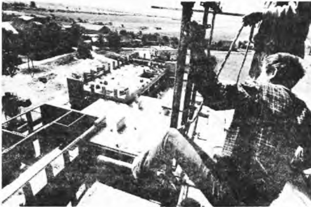
Szkoła w budowie
