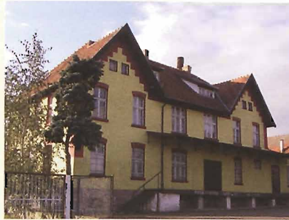
Budynek dawnej mleczarni w Lednogórze
