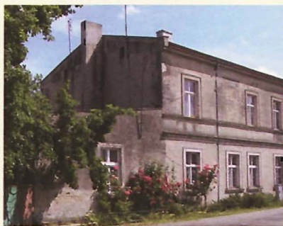
Komorowo. Budynek dawnej oberży
