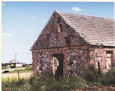
Skrzetuszewo. Budynek o mozaikowej konstrukcji ścian
