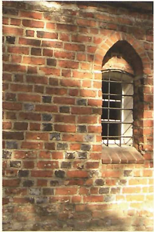
Kłecko. Okrągłe otwory w ścianie kościoła
